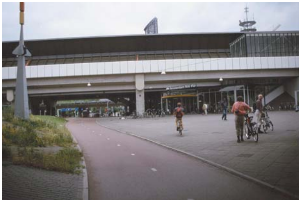
Foto 2.7: Fietsroute met tunnel onder station - Amsterdam
