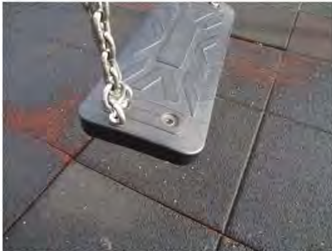
Losse ketting van schommelzitting, kan direct opgelost worden
