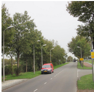
Foto 4.4: 6 masten binnen een afstand van 40 meter duidt op een ondoordacht ontwerp.
