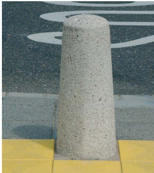
afzetpaal: betonpaal Steady (leverancier Velopa)
