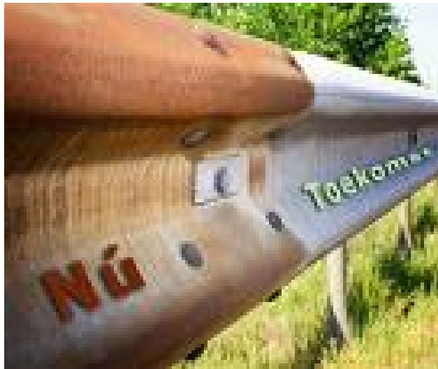
Figuur 2: conserveren geleiderail
