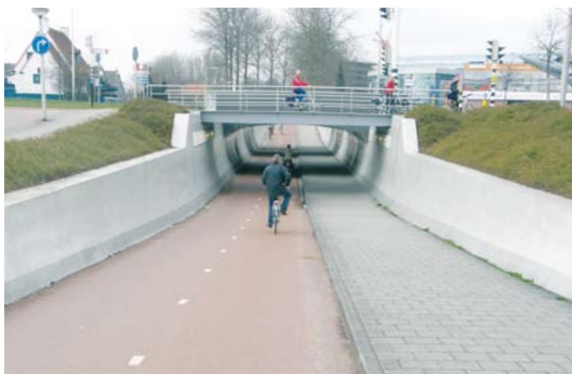
Veilige tunnel (Zwarte Water Allee).
