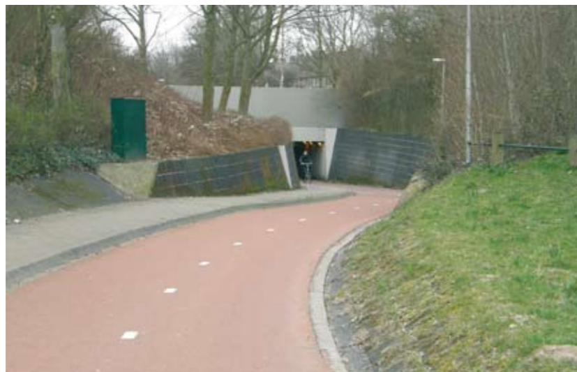
Onveilige tunnel (Ittersum Allee Tunnel).
