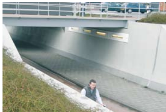
Goede en vandalismebestendige verlichting.
