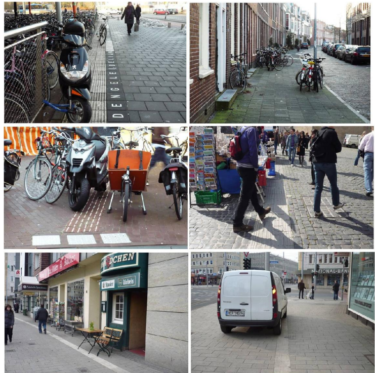
Obstakels voor blinden en slechtzienden
