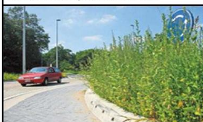
Onkruidgroei tot 50 cm hoogte waardoor bebording niet meer zichtbaar is.
